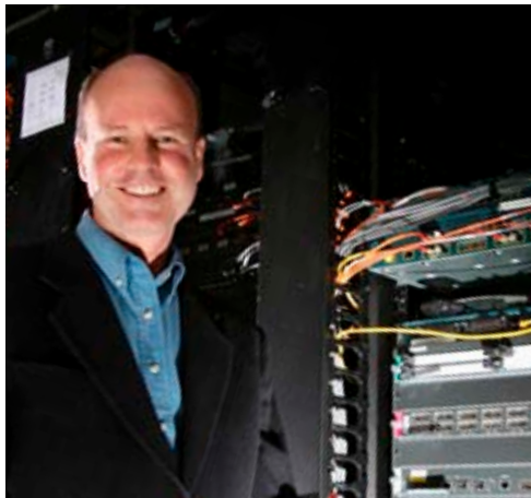
Kevin Emery (データセンター・プランナー)
