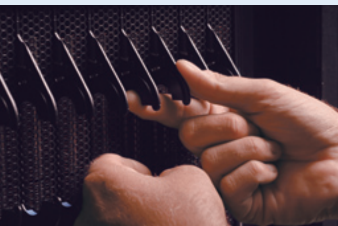
左：インテルのデータセンター内のブレードサーバー 表紙：Jon McGee、データセンター・マネージャー
